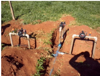
Fig. 8. Válvulas de irrigação automáticas instaladas na propriedade rural. As válvulas recebem as instruções de abertura e fechamento do sistema por meio dos relés solenoides.
