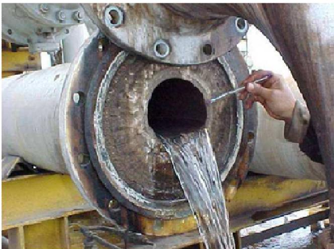
Figura 2 - Incrustação em tubulação de descarte de água
